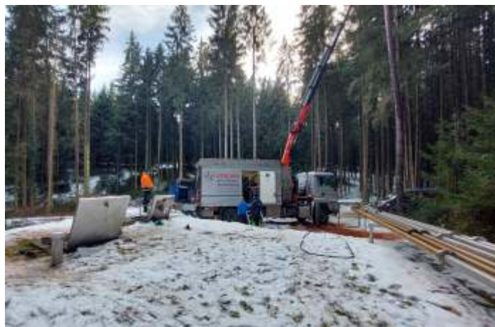
Bild: Brunnenregeneration I – Regenerationsmaßnahme am Brunnen II mit Spezialgerät
