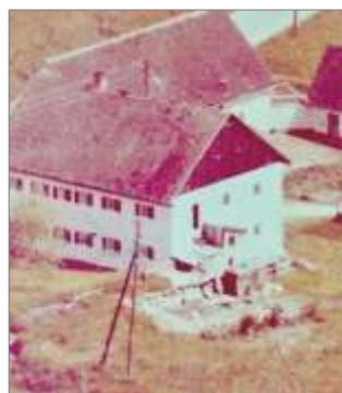
Mühlenanbau im Südosten
